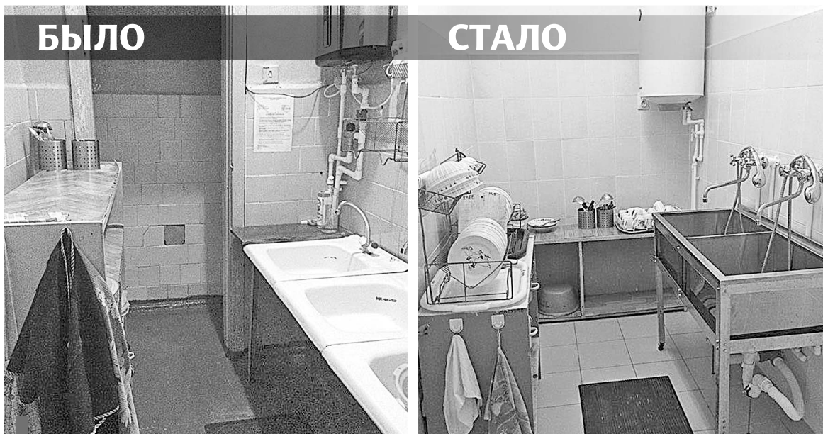
Ремонт буфетных в детском саду №36 (село Курьи)
